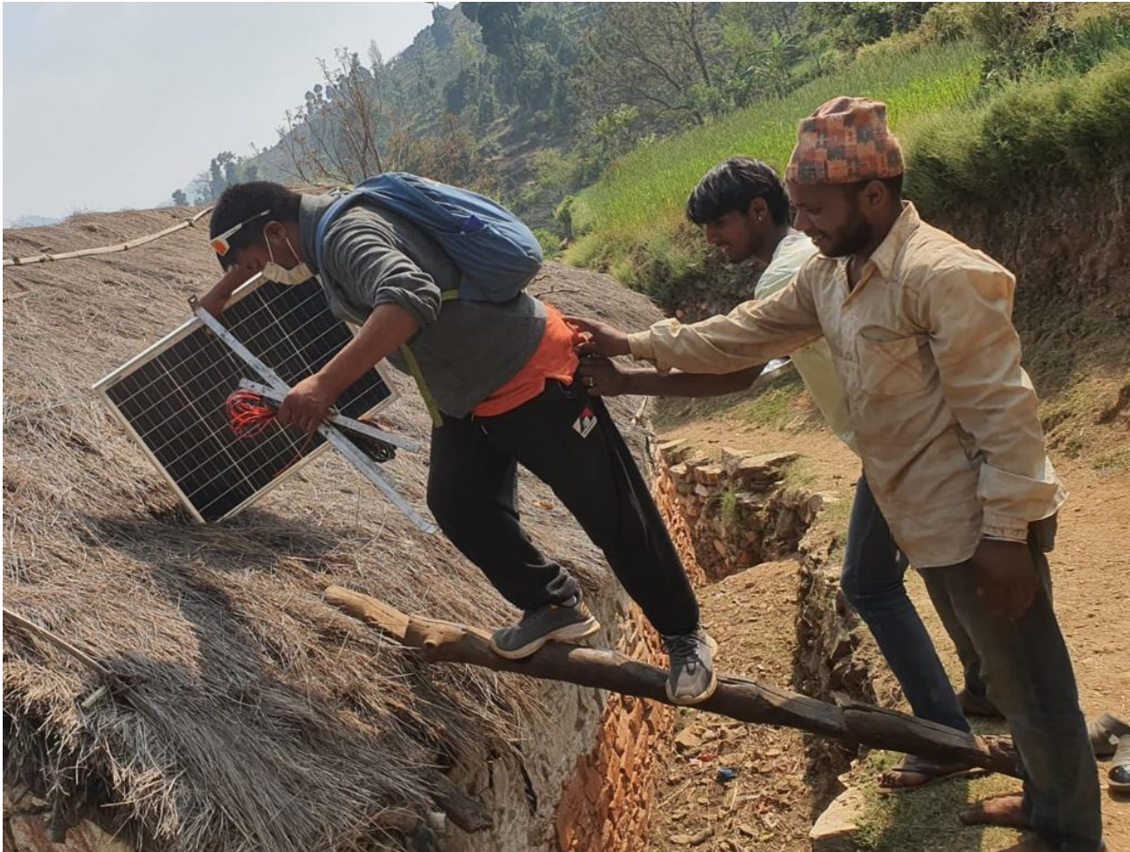
Nicht ganz ungefährlich auf dem Strohdach
